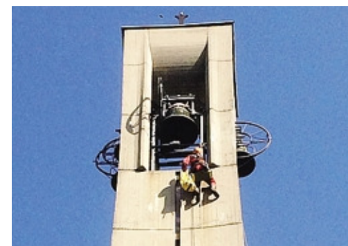
L'ispezione in quota per verificare lo stato
