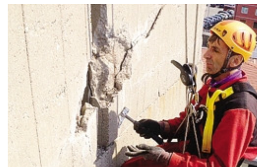
Il controllo delle crepe, l'edificio risale al 1968
